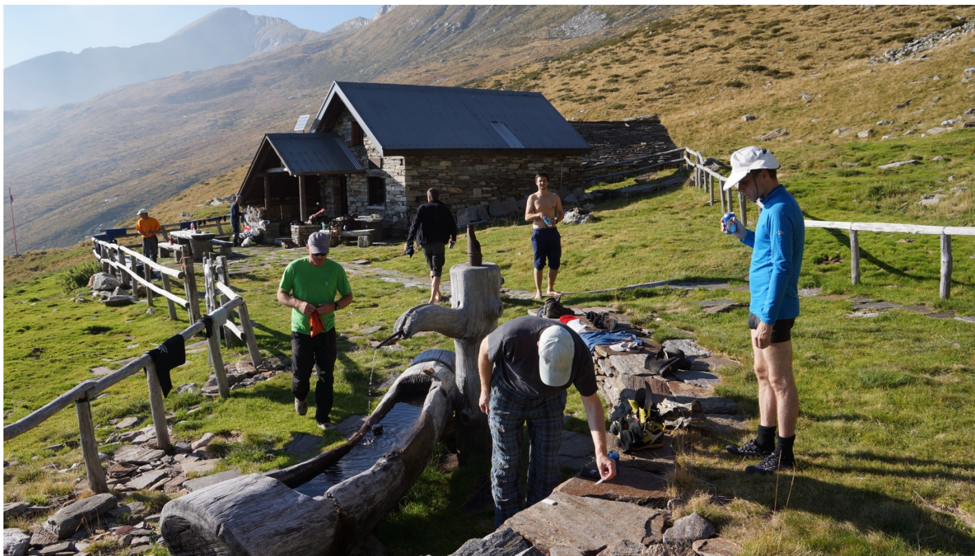
Am Ausgangspunkt der „Via Alta della Verzasca“ die Capanna Borgna
