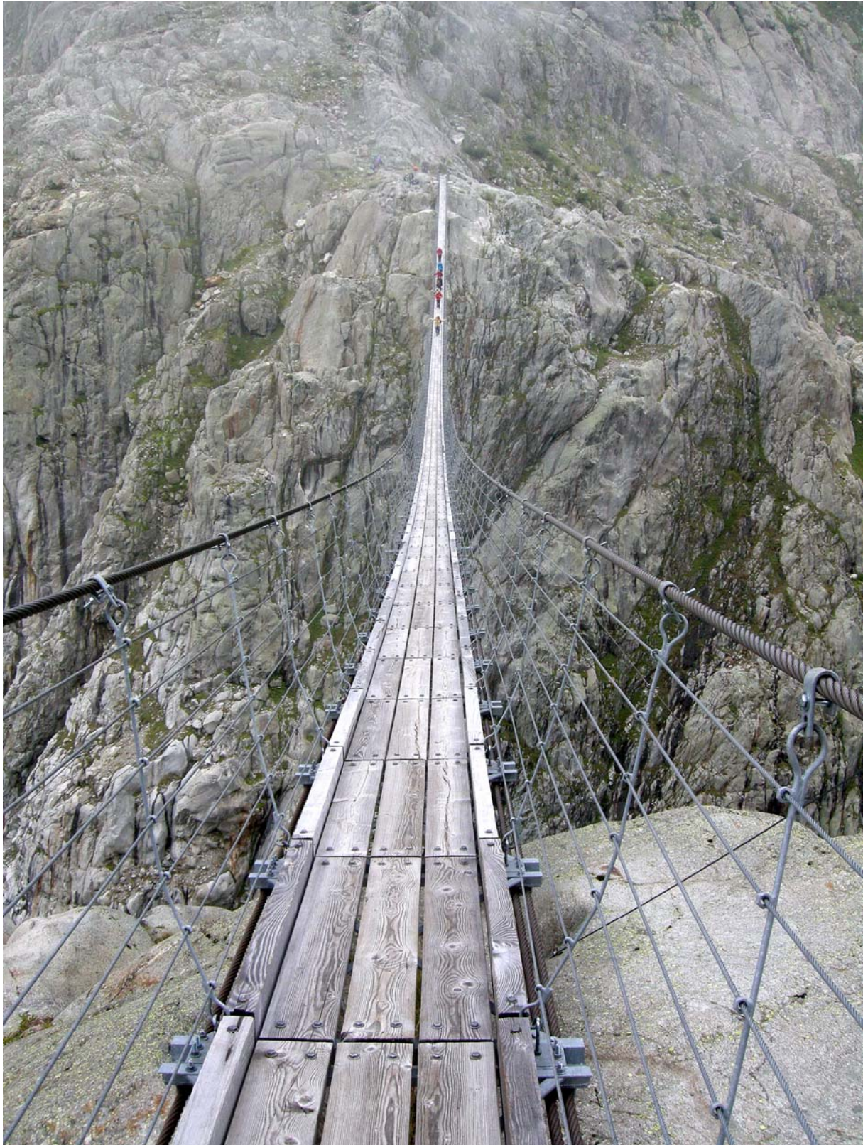
Die Hängebrücke Trift mit nepalesische Bauweise, 170m lang und 100m über dem Seespiegel
