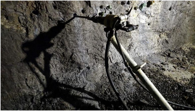
Bohrmaschinen mit Pressluft- und Kühlwasserzufuhr
