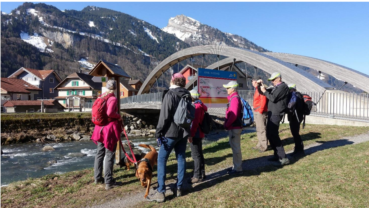
An der Kirchenbrücke neben dem Fluss «Muota»
