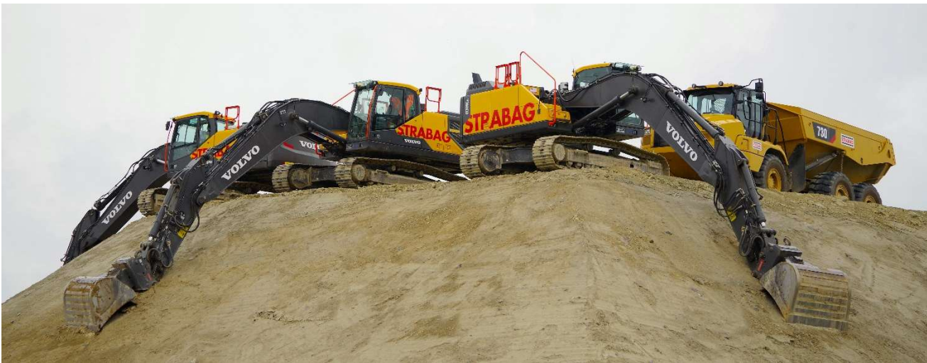
Einfach heiss und frech starren die Bagger bei der Sinser Umfahrung von ihrem Aushub
