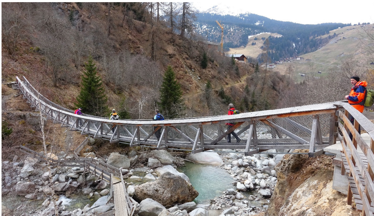
Kurz vor Curaglia die Holzhängebrücke über den Rein da Plattas, ein Zufluss zum Vorderrhein
