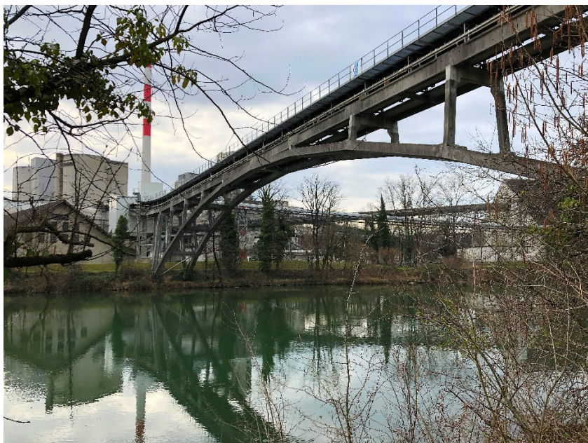
Zement- Förderband über die Aare bei Wildegg
