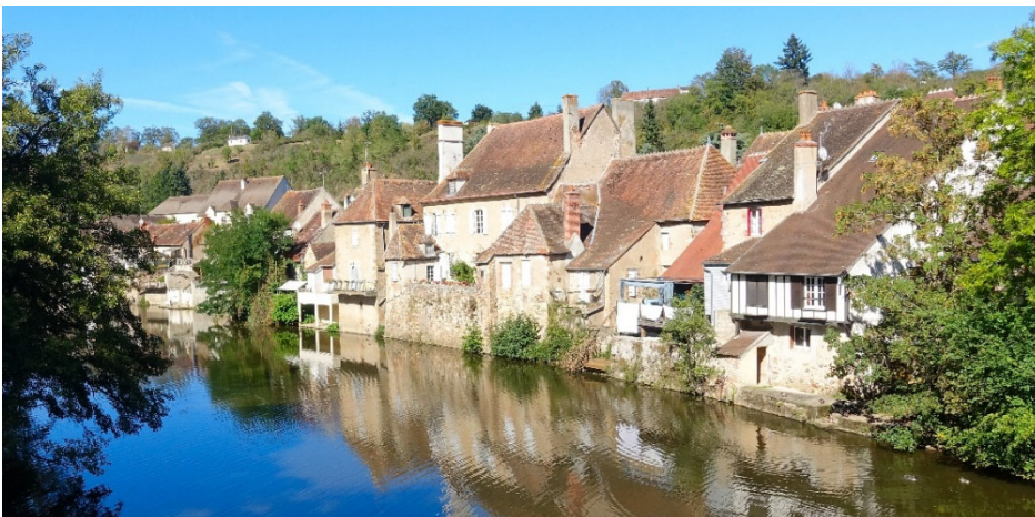
Das Dorf mit seiner Dächer- Vielfalt schliesst direkt an den Fluss Aumance an
